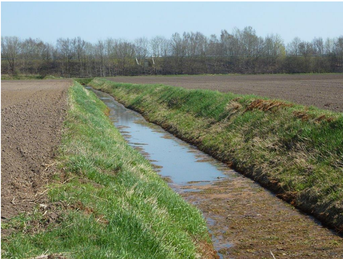
Entwässerungsgraben mit kahlen Böschungen und ohne Seitenstreifen in Astrup, das Wasser ist nährstoff-belastet. Gerade hier sind Uferstreifen notwendig. Foto: BSH
